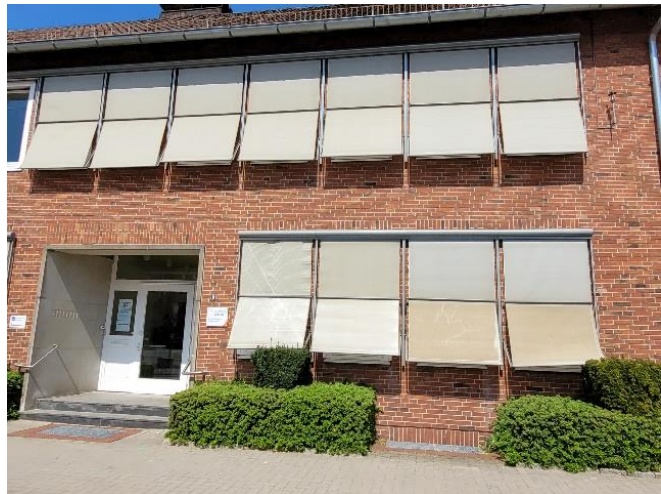
Abbildung 52: Die Jalousien am Gebäude des Gesundheitsamtes Landkreis Vechta halten das Gebäudeinnere länger kühl (Eigene Abbildung: GreenAdapt).
