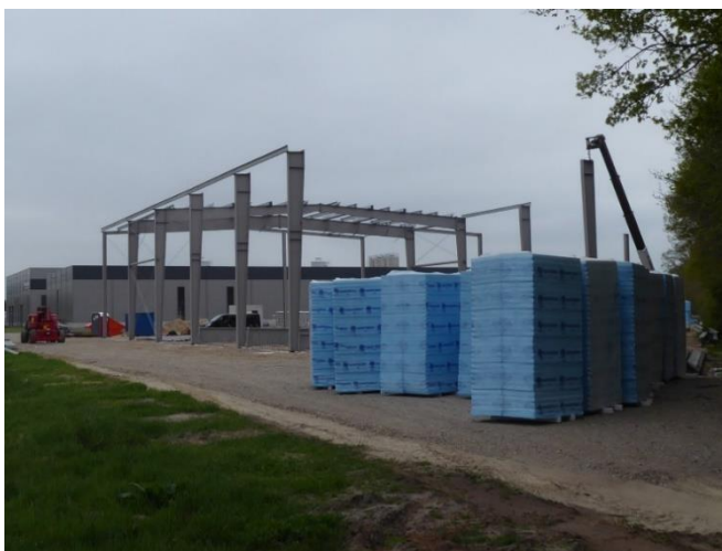
Abbildung 60: Baustelle einer Gewerbehalle im Außenbereich nahe Bakum (Eigene Abbildung: LUP GmbH).
